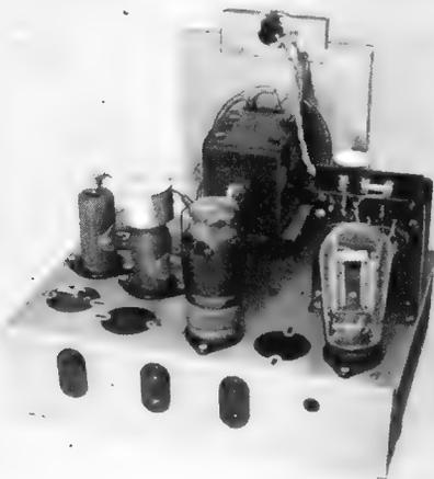
Bild 2. Kleinsuper (Rückansicht)
